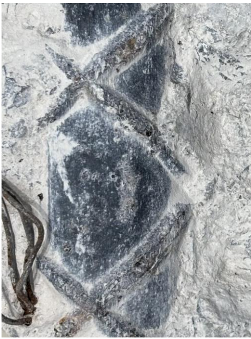
躯体コンクリートの鉄筋腐食状況
