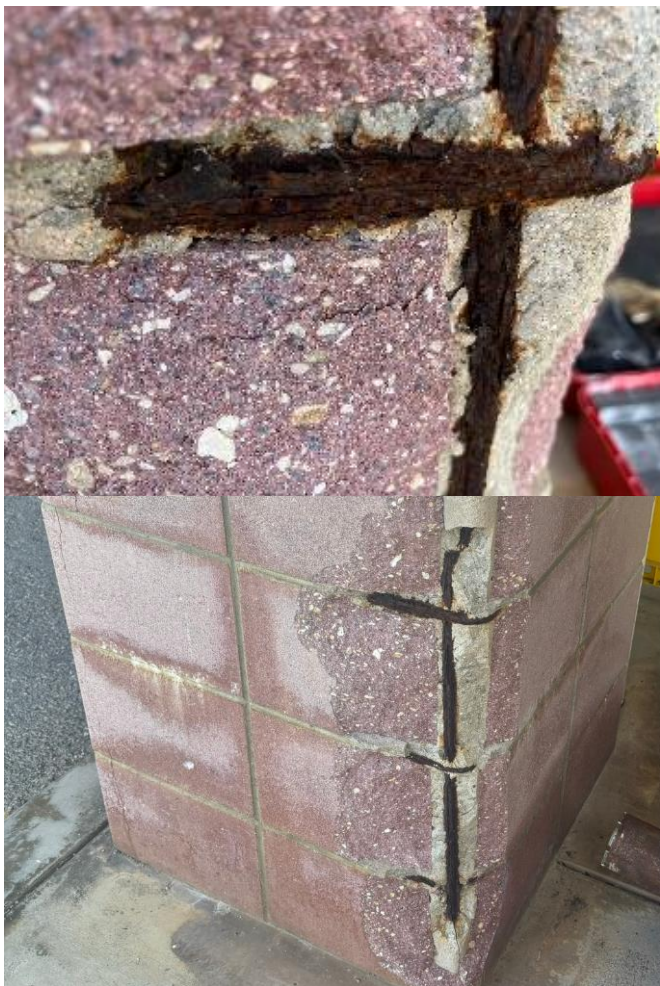
型枠CBの鉄筋腐食状況
