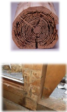
蟻害劣化木材へ合成樹脂を充填する補強方法を確立する。
