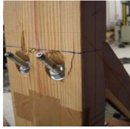
ボルトのめり込み
