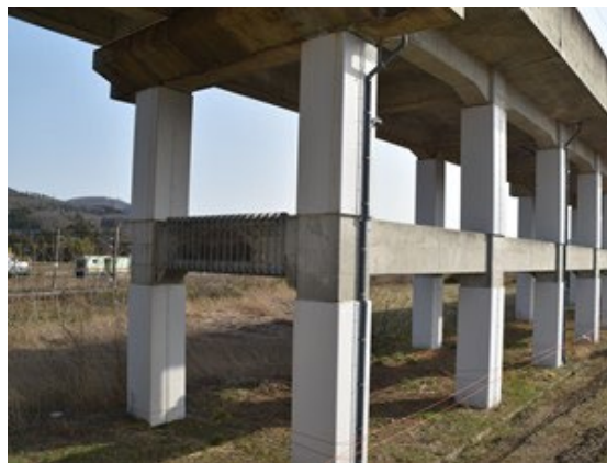
写真 22 高架橋の補修の様子
