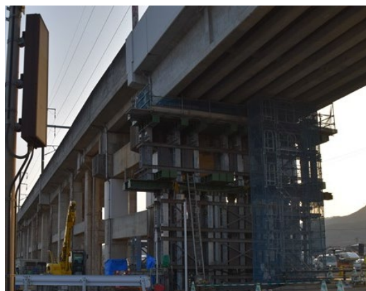
写真 32 高架橋の修復作業の様子
