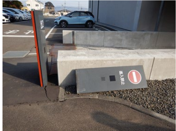
写真 24 表示板の被害
