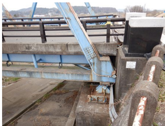
写真 34 橋台周辺の様子
