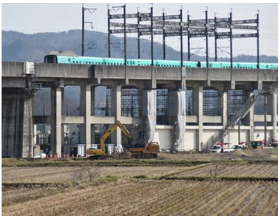
写真 21 新幹線と高架橋の様子
