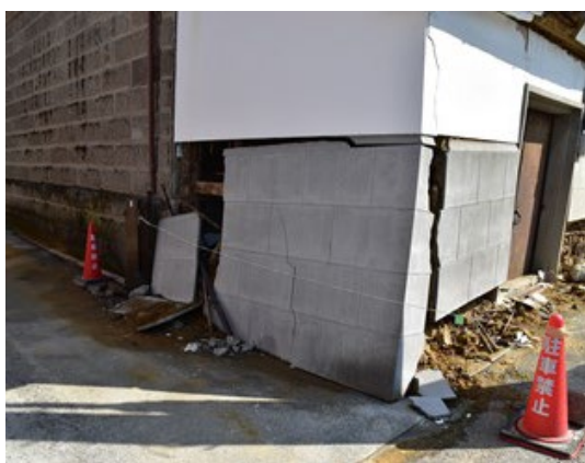
写真 12 外壁の剥落
