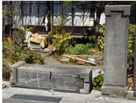
写真 10 門柱の転倒
