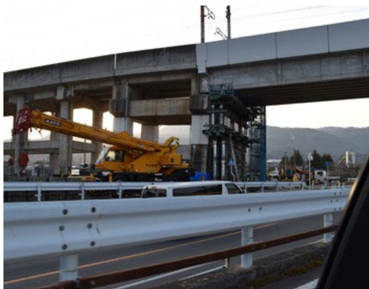
写真 31 新幹線高架橋の様子
