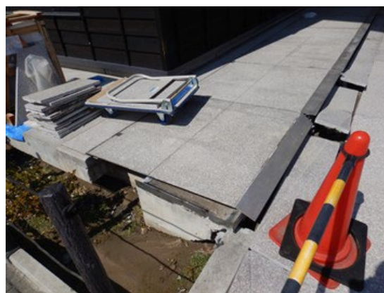
写真 2 免震クリアランス周辺の様子
