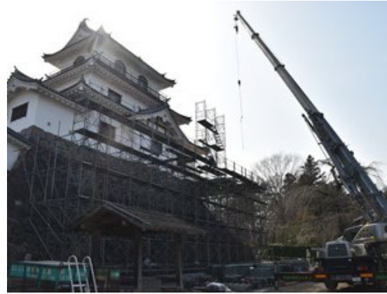
写真 20 白石城の修復工事の様子
